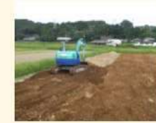
土層改良（客土）
