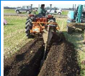
暗渠排水の整備
