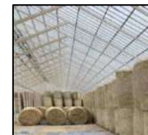
倉庫の整備 （広域流通拠点の整備）
